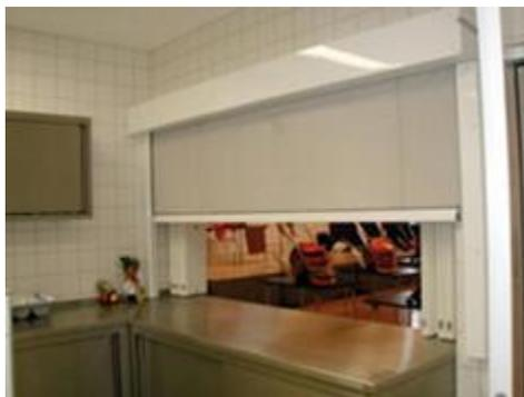
Противопожарные шторы для проёмов по ширине до 4м и высоте до 1.5 м в основном используются для обеспечения огнестойкости заполнения оконных проёмов на фасадах зданий (внутри зданий), передаточных окон в цехах производственных помещений предприятий, помещений столовых и кафе для приготовления пищи, хлебобулочных изделий, проекционных окон технических помещений театров и кинотеатров.
